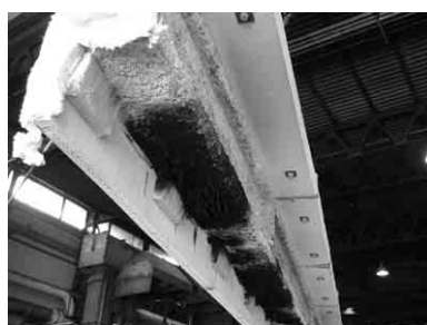
写真4 梁試験体 Photo 4 Beam specimen
